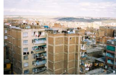
Resim 15 Sur İçinin Kuzeydoğu Görünümü
